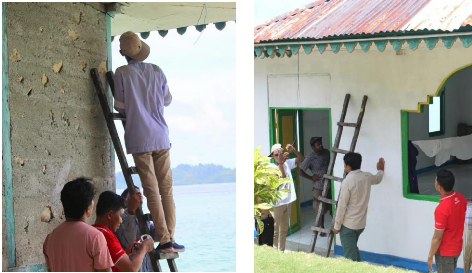
Gambar 2 proses instalas penerangan teras mesjid
