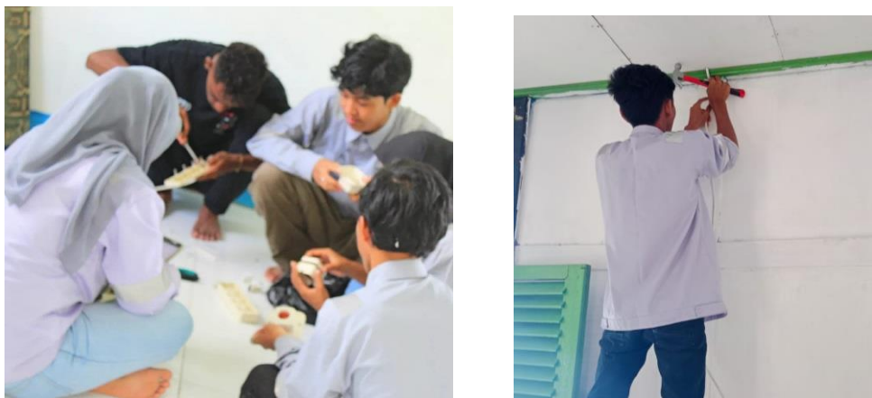
Gambar 3 perakitan stop kontak dan pemasangan saklar
